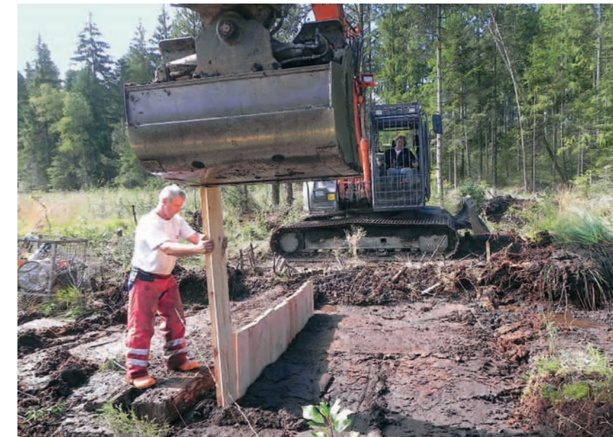
Ein Bagger hilft mit: Bei einem Teil der 25 Stauwehre im Haubacher Moos wurden Spundwände aus Holz ingerammt. Foto: Rita Strieckmann.
